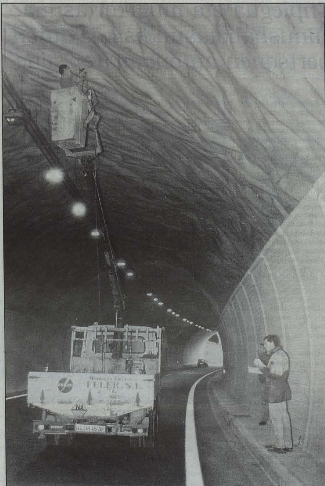
Geoconsult Madrilgo enpresako kideak zundaketak egiten ari dira tuneletan.
